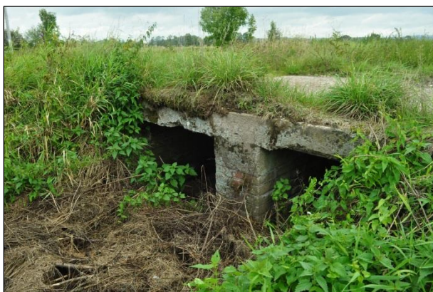
Foto 29: Propustek zanesený organickým odpadem
