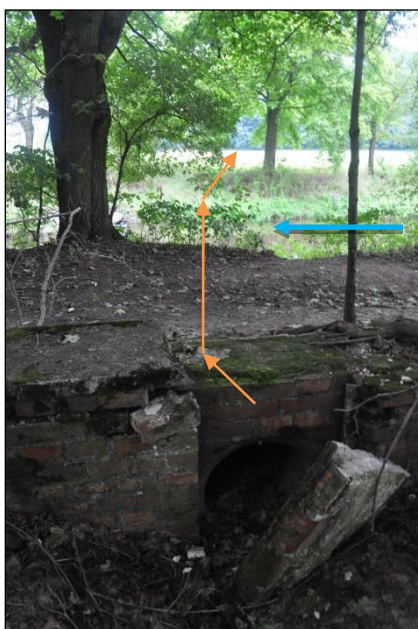
Foto 11: Nátok do potrubí shybky vedené pod korytem řeky Metuje
