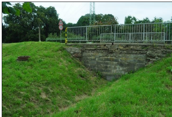
Foto 4: Most se zazděnou propustí (ochrana před vtokem do soukromých zahrad)
