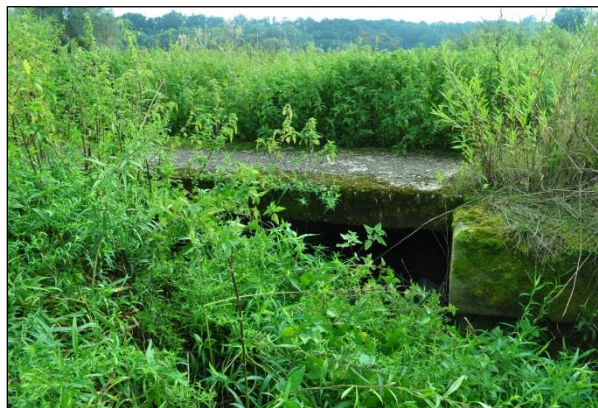
Foto 13: Zanesený nátok do koryta zavlažovacího kanálu
