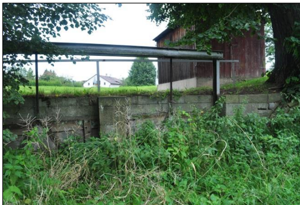
Foto 1: Zarostlé a ztrouchnivělé části stavidla
