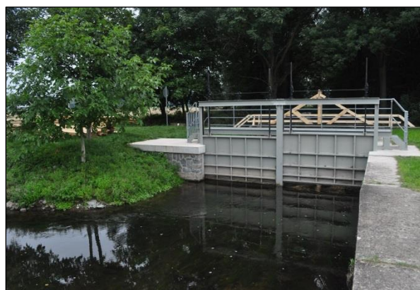
Foto 8: Nově vybudované stavidlo Mlýnského náhonu. V pozadí původní stavidlo
